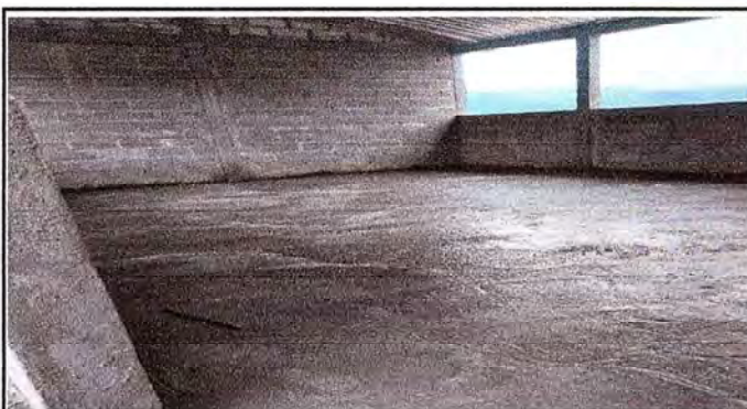
Foto 3: SUSTITUCION DE PISO DE AULAS 1 Y 2
