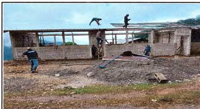
Foto 4: SUSTITUCION DE ENTECHADO DE AULAS 1 Y 2
