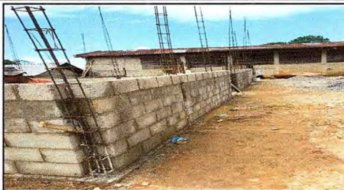
Foto 2: SUSTITUCION DE PAREDES AULA 1 Y 2
