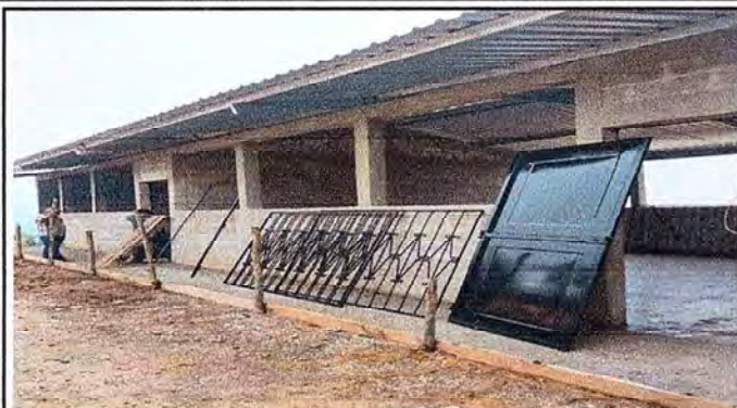
Foto 1: SUSTITUCION DE PUERTAS, PISO Y BALCONES
